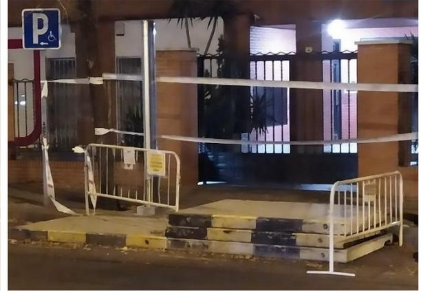
Imagen 2: Bloques de hormigón usados en paradas provisionales de EMT Madrid.
