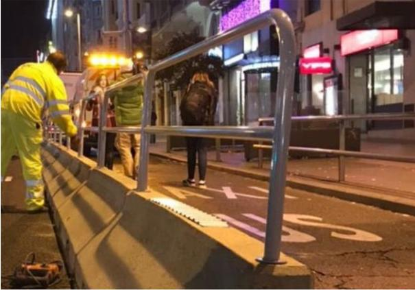
Imagen 1: Ejemplo de valla tipo, instaladas en Gran Vía en el año 2018.
